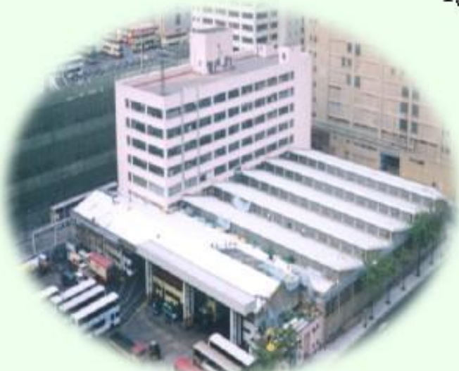
更換屋宇天面坑片及防水
