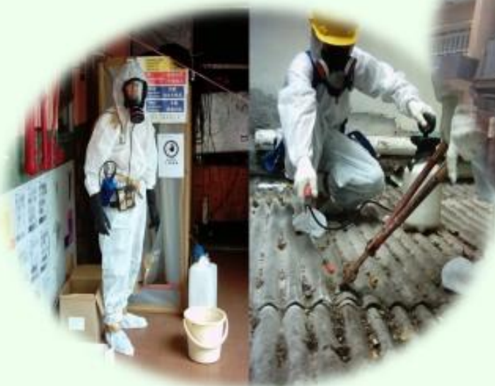
石棉檢查及清拆
