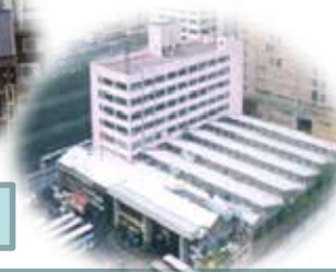
更換屋宇天面坑片及防水
