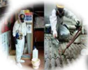
石棉檢查及清拆
