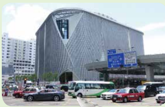
西九戲曲中心 橢圓通結構柱
