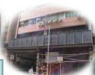
石矢簷篷拆卸
