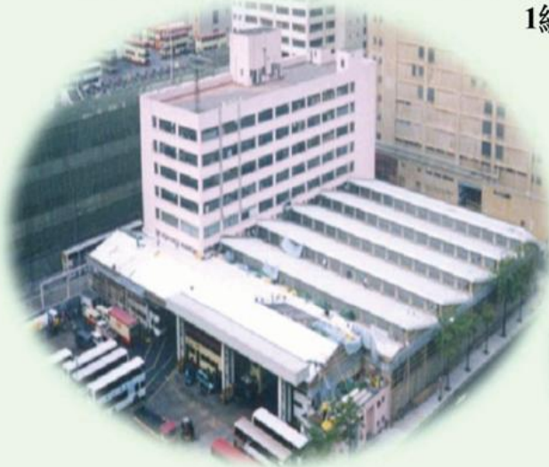
更換屋宇天面坑片及防水
