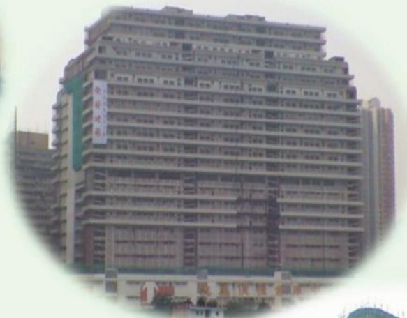
緊急屋宇結構鞏固
