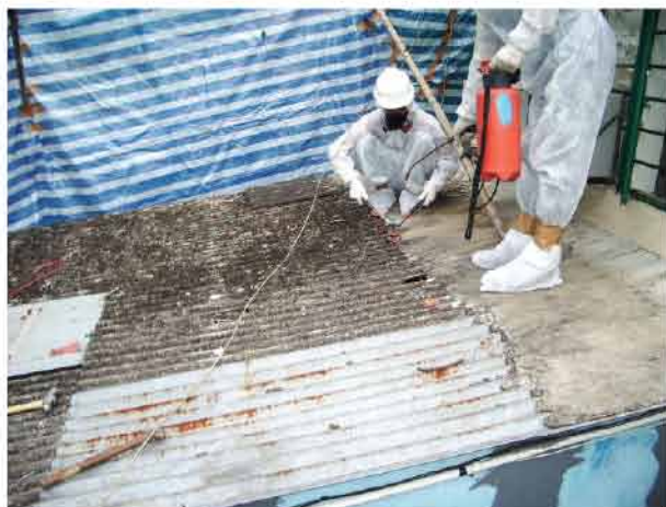
石棉檢查及清拆
