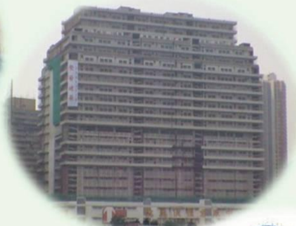
緊急屋宇結構鞏固
