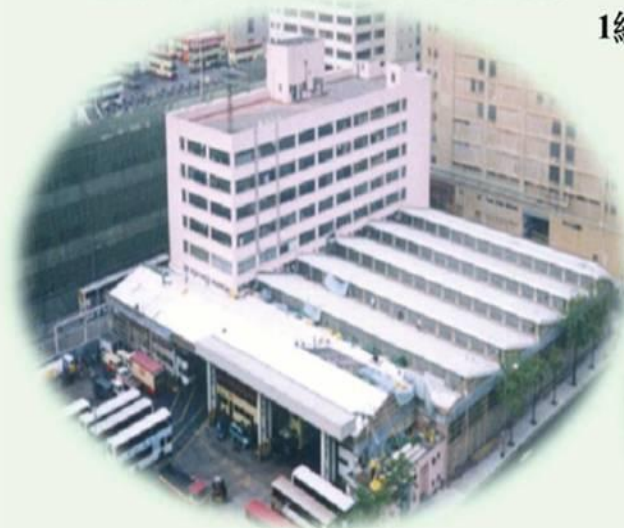
更換屋宇天面坑片及防水
